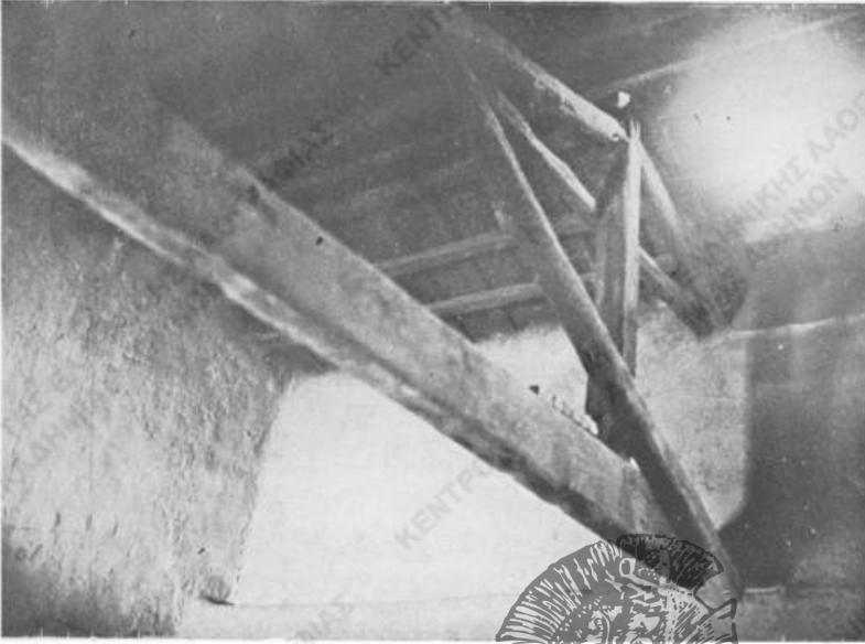
1. Δοκός και στηρίγματα της στέγης της οίκιας Π. Κόμαρη εις τὸ χωρίον Καραβία. (Εἰς τὸν φωτεινὸν κύκλον τὸ ἄνοιγμα τοῦ φεγγίτου).
