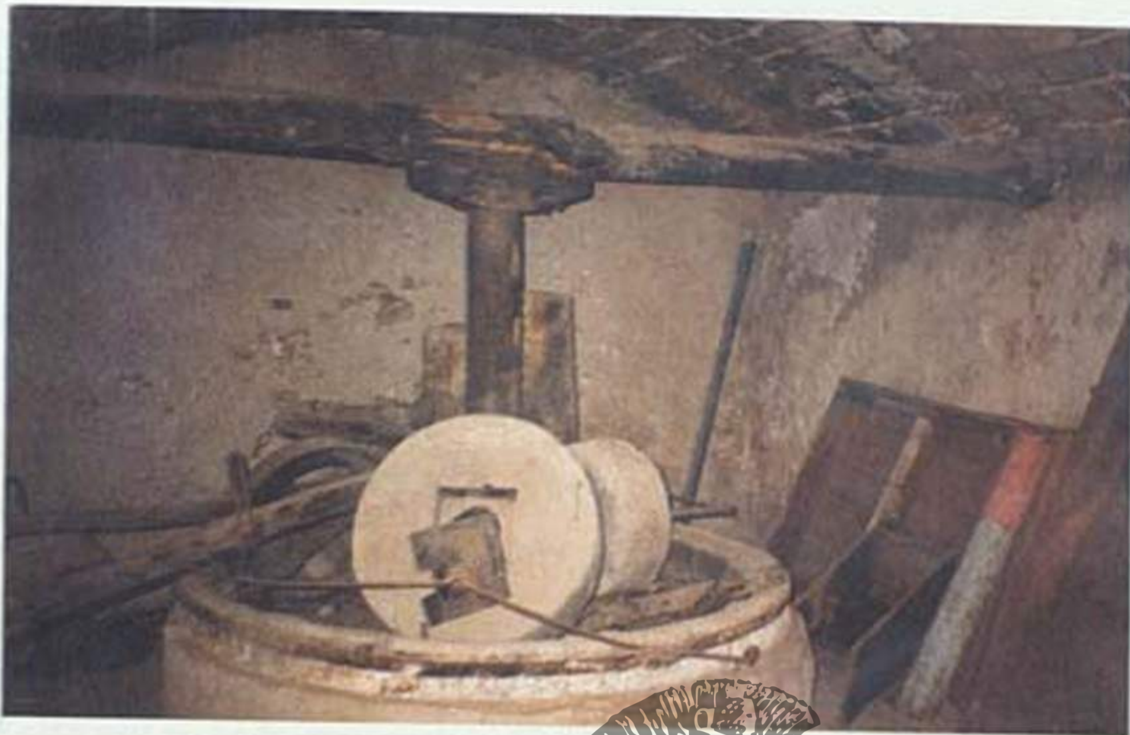
Εικ. 10. Ο χώρος αλέσεως του ελαιοκάρπου με τις αλλαγές, τη βάση κ.λπ. του μύλου στο παλαιό ελαιοτριβείο (φάμπρικα) της Μονής Αγίας Τριάδας των Τσαγκαρόλων στα Ακρωτήρι Χανίων. Βρίσκεται σε υπόγειο χώρο στο εμπροσθό τμήμα της μονής, κάτω από την είσοδό της. (Φωτ. Παναγ. Καμηλάκη, 1999).
