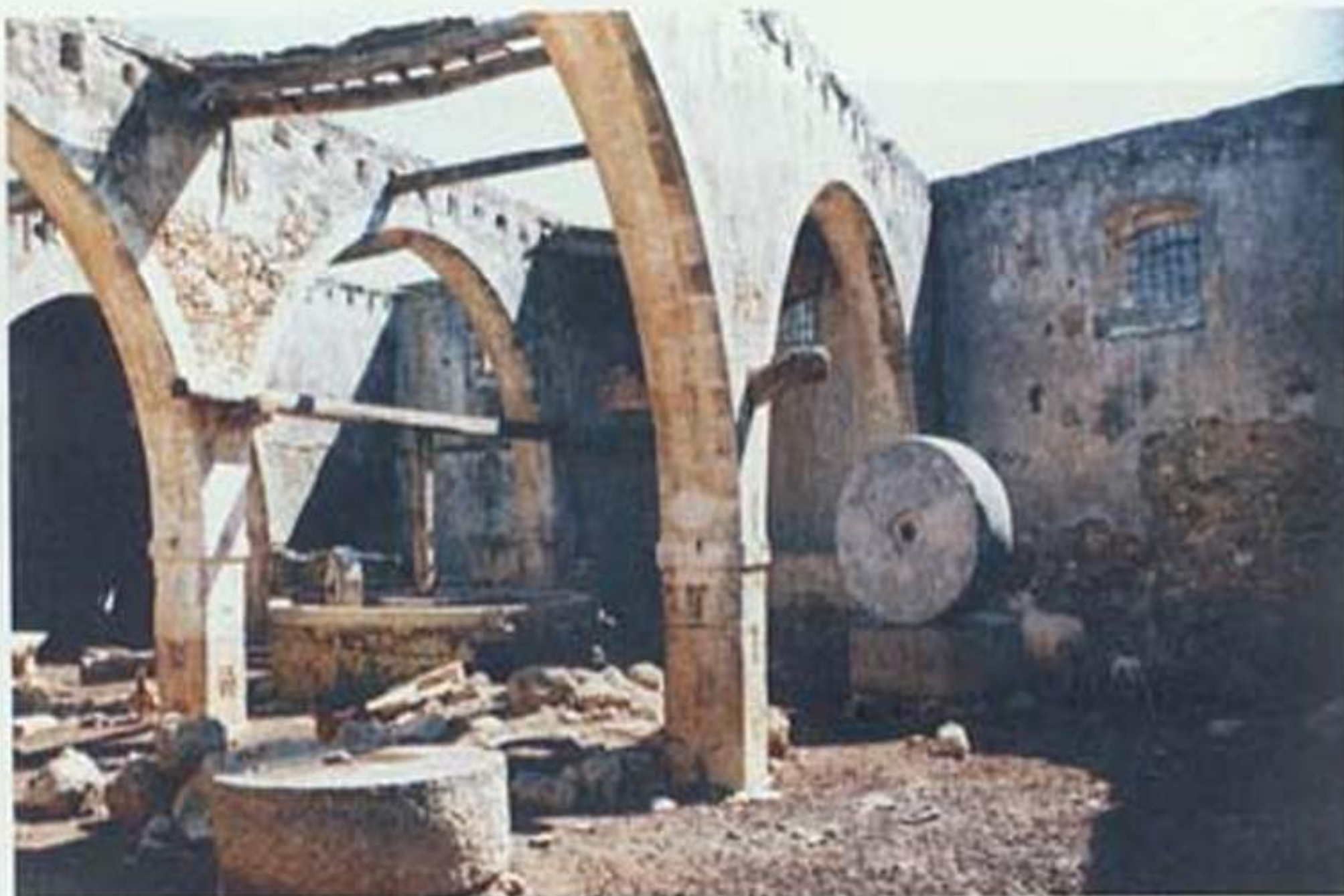
Εικ. 3. Ερείπια μεγάλου ελαιοτριβείου της βενετοκρατίας με πολλές καμάρες στον πύργο του χωριού Μαρούσις Ρεθύμνου. Διακρίνονται η βάση του μύλου, η κατώπετρα, πάνω στην οποία γυρνούσαν τα μύλκρια (μυλόπετρες), το κάθετο ξύλο, γύρω από το οποίο περιστρέφονταν οι μυλόπετρες, διάφορες μυλόπετρες κ.ά. (Φωτ. Χρυσούλας Ζήκου, την εποχή της εγγραφοί και από εμάς, Χανιά 2009).
