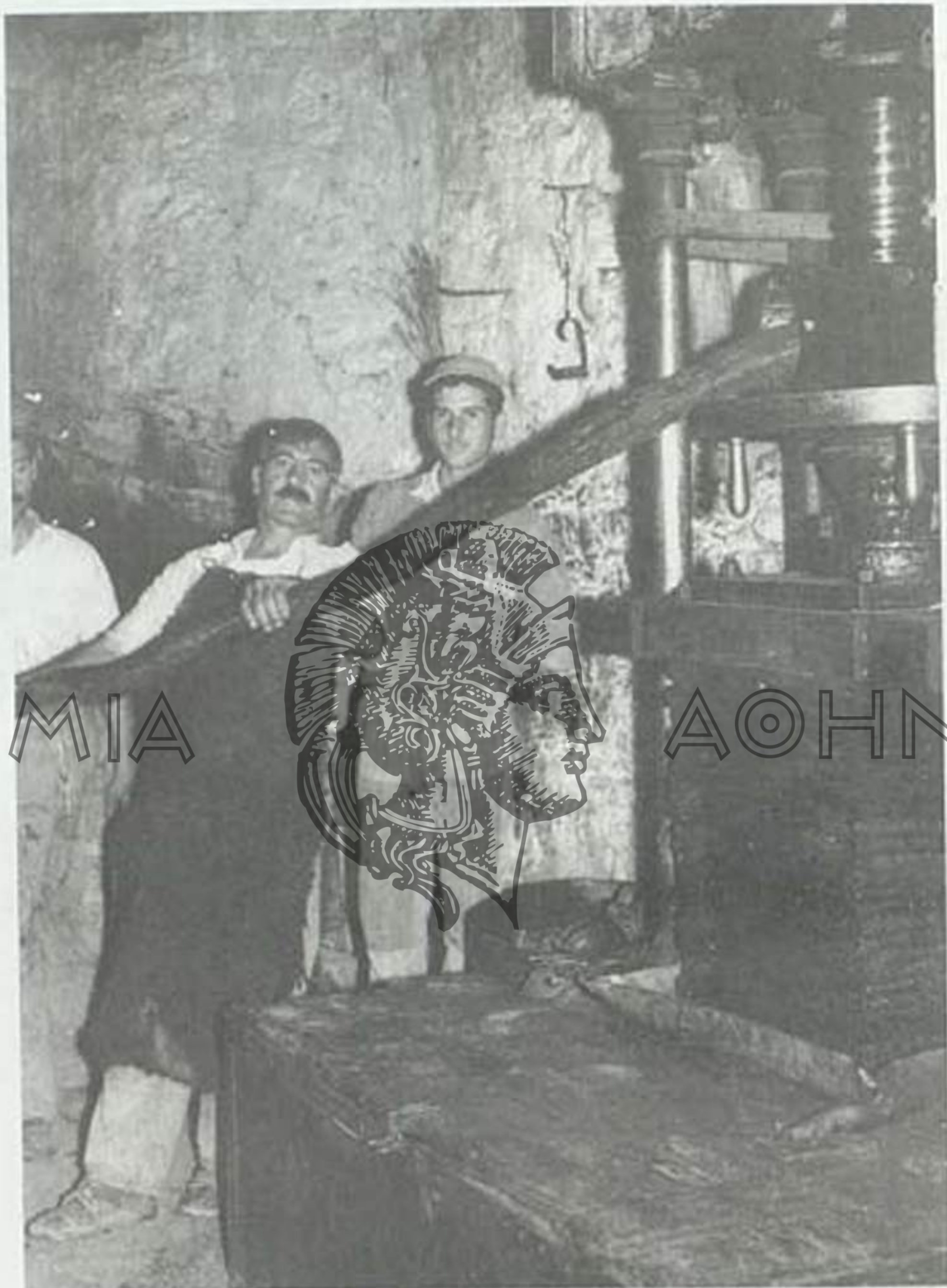
Εικ. 6. Οι εργάτες ελαιοτριβείου (αλιτριβιδιάρηδες) στο Λασιθί γυρίζουν με δύναμη τον μοχλό, που κατεβάζει το πάνω μέρος της φάμπρικας, για να συμπιεστούν οι ελιές. (Φωτ. Κώστα Παπασηφάκη, Νεάπολη Λασιθίου, από το φωτογραφικό αρχείο του Σ.Ε.Δ.Η.Κ., Χανιά).
