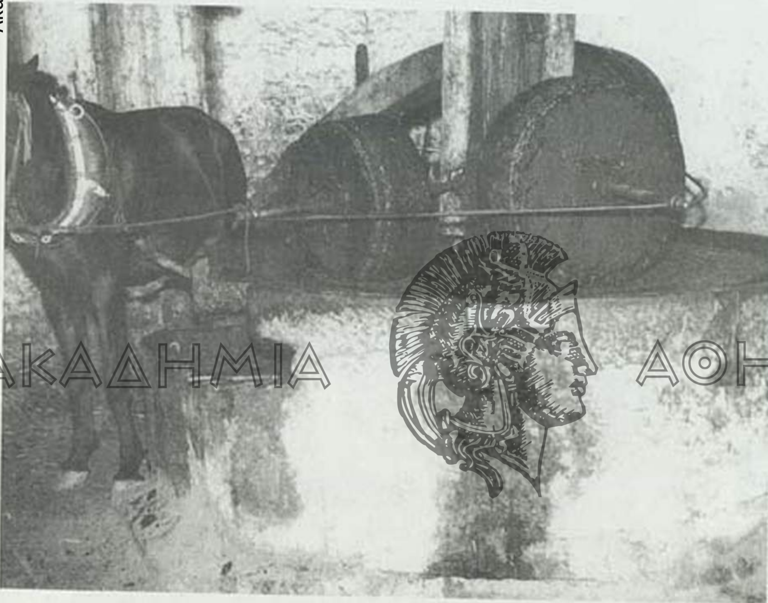
Ειχ. 5. Αλογο γυρίζει τις μυλόπετρες ελαιοτριβείου στο Λασιθι. (Φωτ. Κώστα Παπασηφάκη, Νεάπολη Λασιθίου, από το φωτογραφικό αρχείο του Σ.Ε.Δ.Η.Κ., Χανιά).
