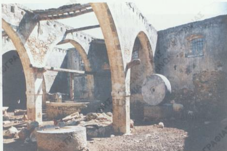
Εικ. 3. Ερείπια μεγάλου ελαιουργείου της βενετοκρατίας με πολλές καμάρες στον πύργο του χωριού Μαυροκράβη, όπου διακρίνονται η βάση του μύλου, η κατώπετρα, πάνω στην οποία περιστρέφονταν οι μύλινες (μυλόπετρες), το κάθετο ξύλο, γύρω από το οποίο περιστρέφονταν οι μύλινες, διάφορες μυλόπετρες κ.ά. (Φωτ. Χρυσούλας Ζήγκου, από το βιβλίο της Χανιά, 1999).
